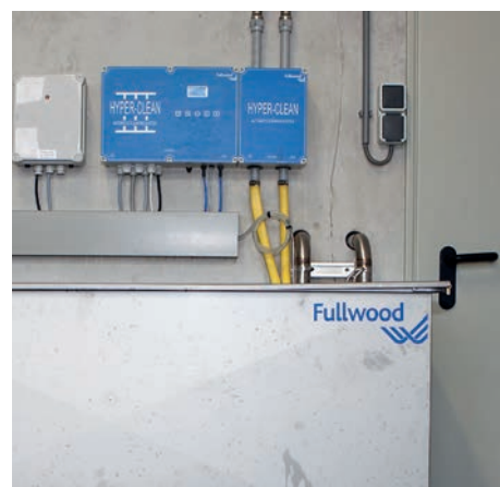
Tijdens de koude naspoeling controleert de Sensomatic of alle chemicaliën verwijderd zijn.
